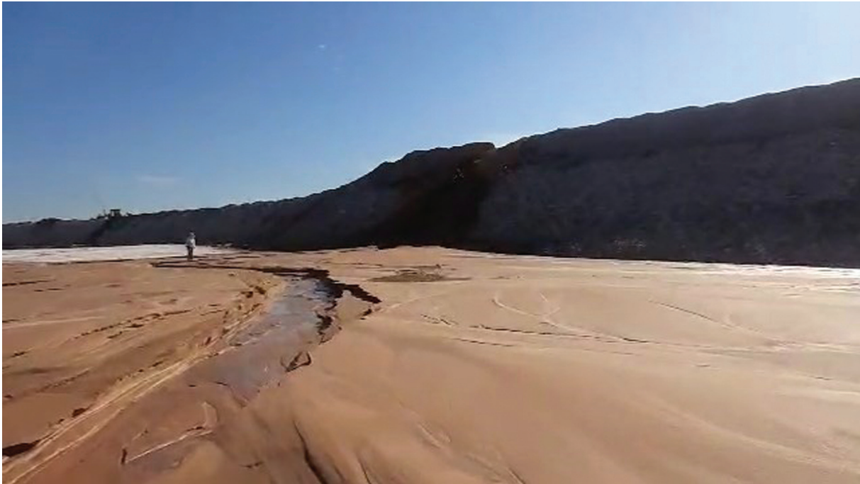
Рисунок 3 – Участок поверхности пласт-плиты, пересеченной глубокими промоинами
