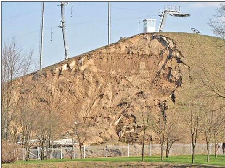
**Рисунок 4** – Оползень срезания на склоне «Лысой горы» Минской возвышенности, сложенном ледниковыми песчано-глинистыми грунтами [11]
