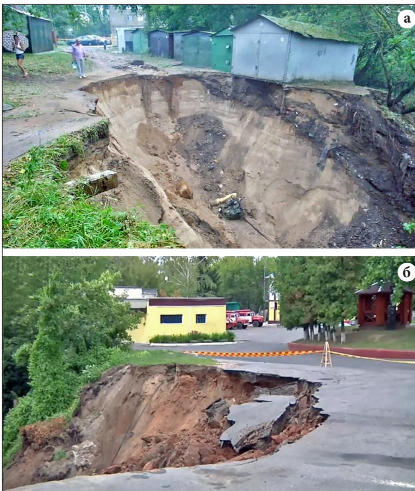
Рисунок 3 – Оползни срезания на склонах оврагов, сложенных водно-ледниковыми пылеватými песками в Гродно (а) и моренными супесями в Мозыре (б) [10; 12]
