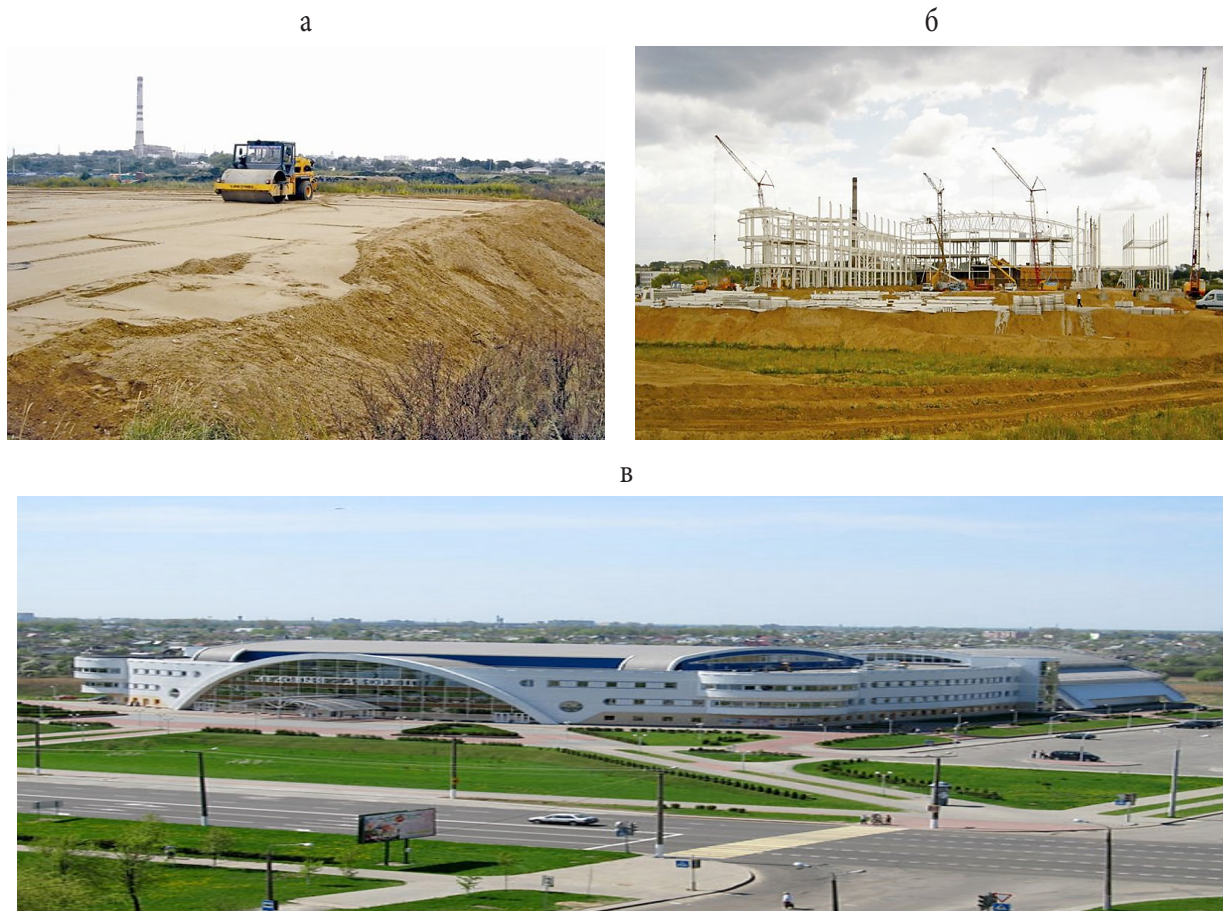
Рисунок 4 – Селитшебная ЭГС в районе Ледового дворца с залом акробатики в г. Барановичи: а – подготовка площадки строительства дворца; б – этап строительства; в – современный вид [10]
